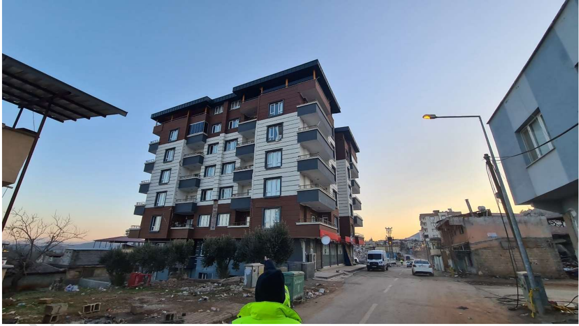
Şekil 3.37. Deprem sonrası hasarsız bina (İslâhiye)
