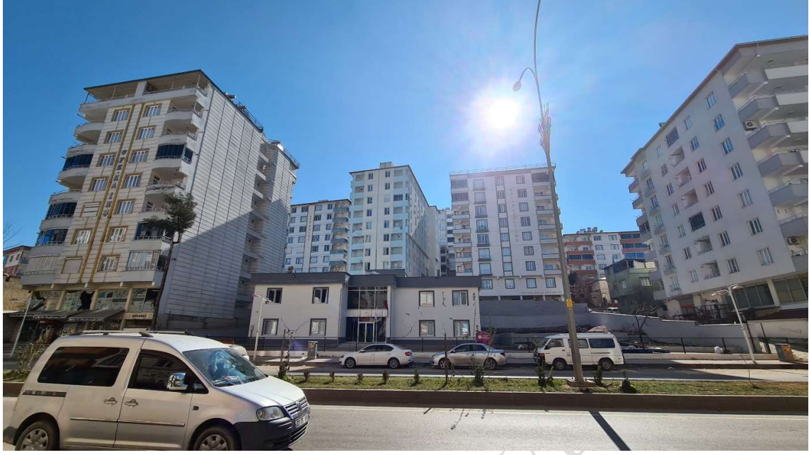
Şekil 3.36. Deprem sonrası hasarsız bina (Pazarcık)
