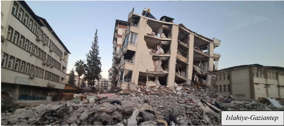
Şekil 3.17. Toptan göçme şeklinde yıkılan binalar
