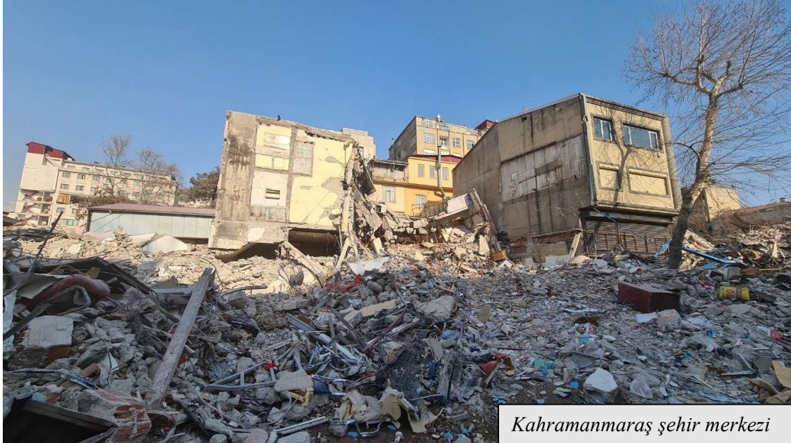
Şekil 3.16. Toptan göçme şeklinde yıkılan binalar
