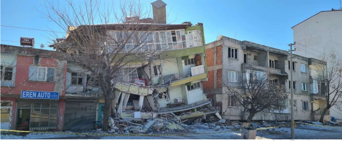
Şekil 3.25. Alt katında dükân olan kısmi göçmüş bina (Gölbaşı)
