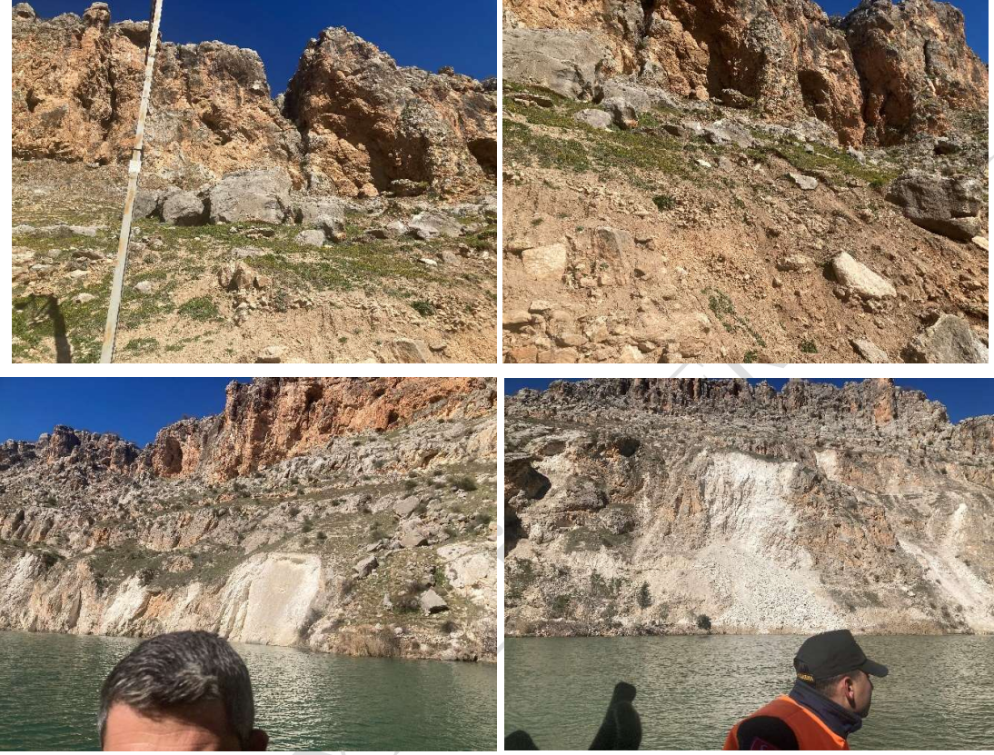
Şekil 3.5. Kopma sonucu şevde asılı kalan kaya blokları (Birecik Baraj Gölü)
