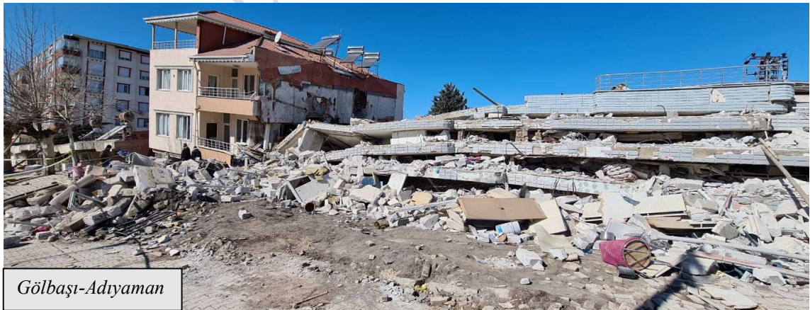
Şekil 3.18. Toptan göçme şeklinde yıkılan binalar
