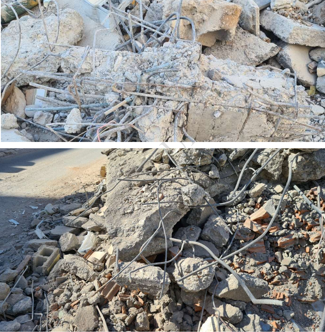
Şekil 3.19. Toptan göçen binalarda etriye yetersizliği
