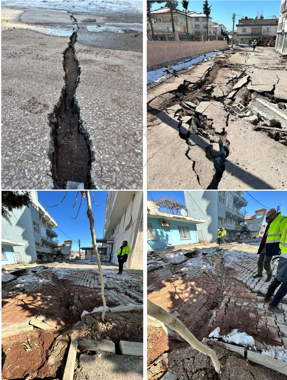
Şekil 3.8. Gölbaşı- Adıyaman fay hattında yer alan yol kaplamasında meydana gelen bozulma
