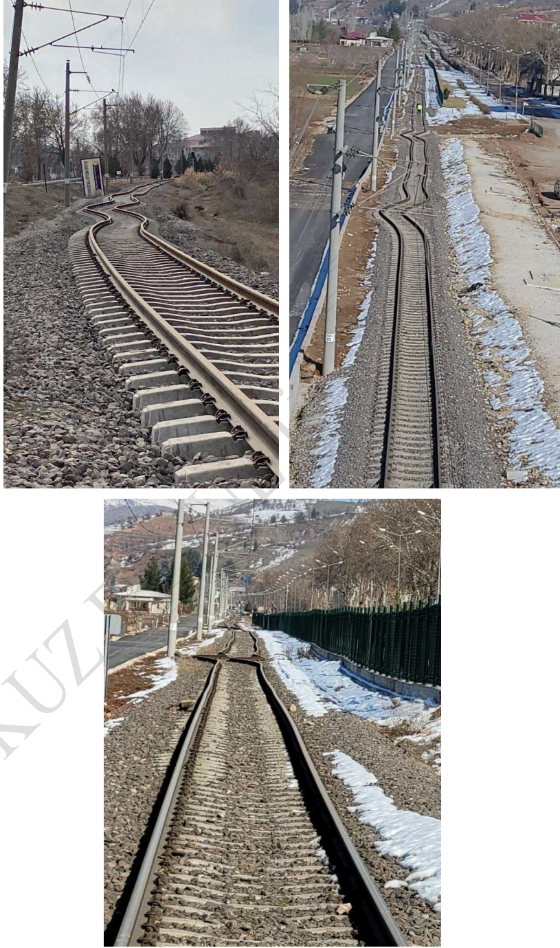
Şekil 3.9. Gölbaşı – Adıyaman Demiryolu üzerinde meydana gelen hasarlar
