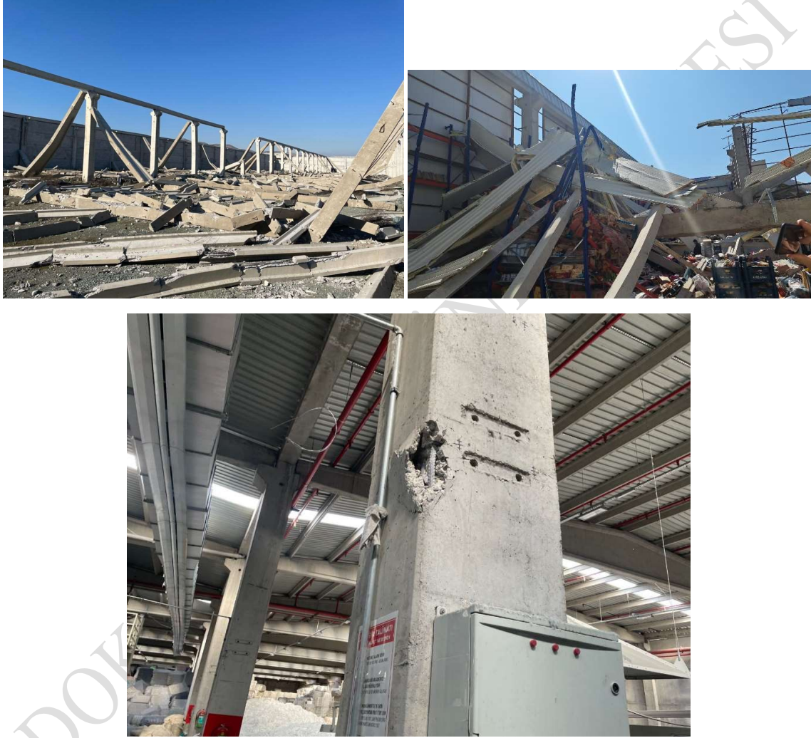
Şekil 3.20. Prefabrik elemanlarda tespit edilen hasarlar (Eski mezunumuz Alper Askay tarafından çekilmiştir, Kahramanmaraş)
