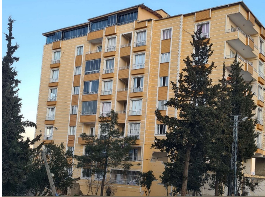
Şekil 3.34. Deprem sonrası hasarsız bina
