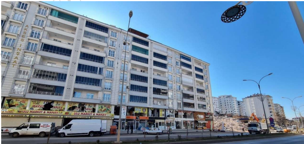
Şekil 3.35. Deprem sonrası hasarsız bina (Pazarcık)
