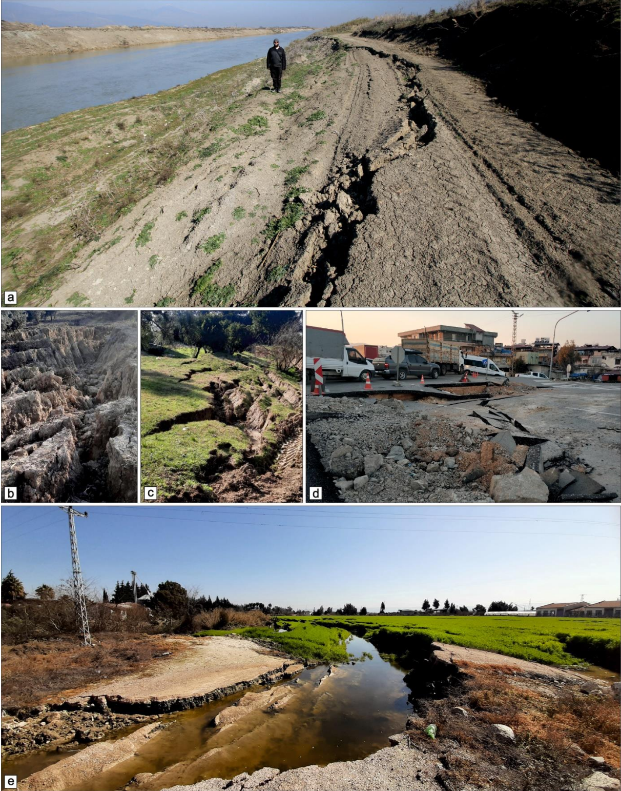
Şekil 2.6 İlk büyük depremin etki alanında (a) Karasu Çayı'nın yapay kanalları boyunca, (b ve c) Kırıkhan doğusundaki tarlalarda kademeli geometrideki yanıl yayılma yapıları. Sırasıyla Antakya-Cilvegözü karayolu (d) ve Demirköprü mahallesinde Asi Nehri boyunca (e) gözlenen yanıl yayılma yapıları.
