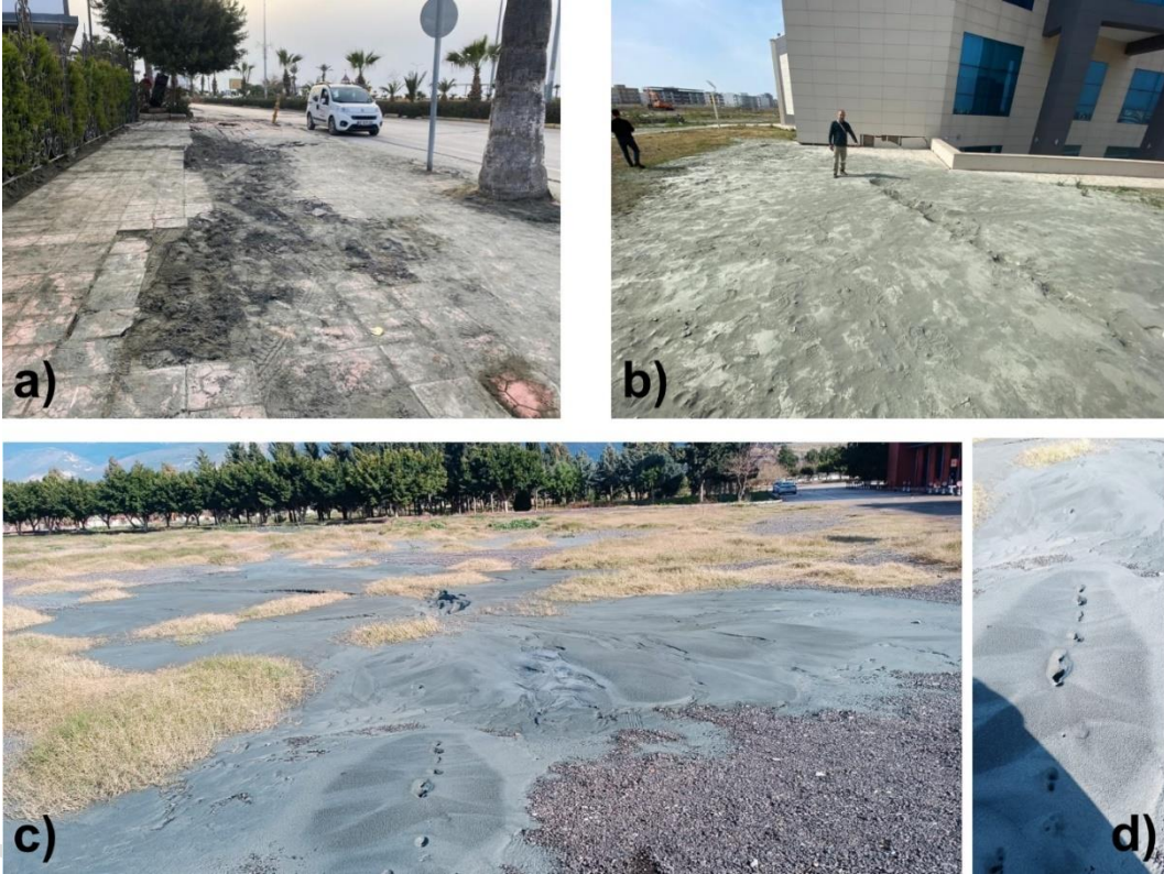
Şekil 4. Saha çalışmalarında gözlenen sıvılaşma yapılarına ait görseller. a) Sahil şeridinde, b), c) ve d) İskenderun Teknik Üniversitesi kampüsü içerisinde karşılaşılan sıvılaşma yapılarına ait görseller (c ve d görselleri Dr. Öğr. Üy. Muhammet Musab Erdem, İSTE İnşaat Mühendisliği Bölümü, tarafından Şubat 2023 tarihinde çekilmiştir).
