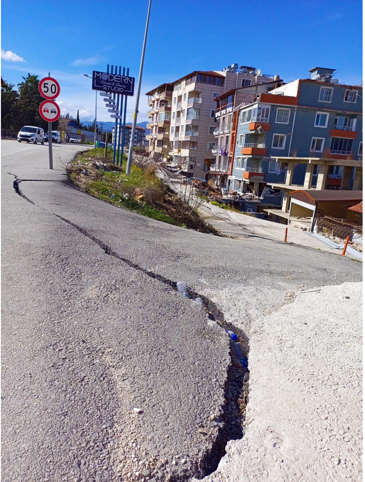
Antakya'da gözlenen yüzey deformasyonları
